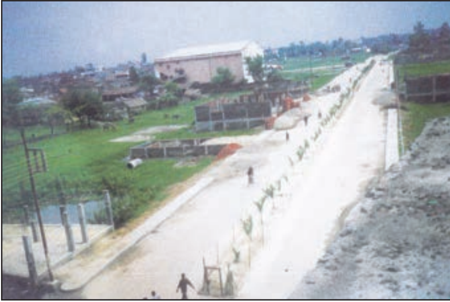
धमाधम भवन निर्माण गर्दै । सदर लाईन बजार, नेपालगञ्ज
