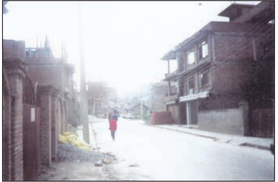
पूर्वाधारहरु सहितको विकसित घडेरीहरुमा भवनहरु निर्माण हुँदै । डल्लु, काठमाण्डौ
